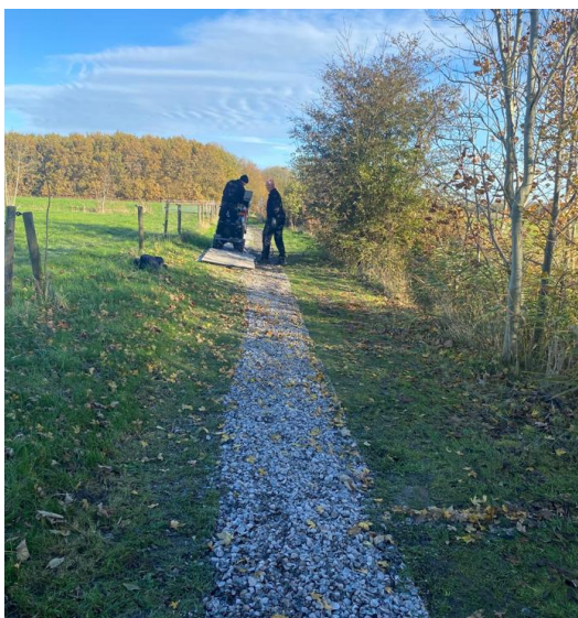
Werk in uitvoering bij het Ede Staal pad
