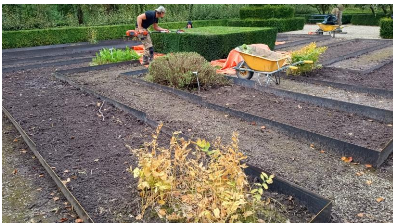
Werk aan de kruidentuin: aanbrengen van cortenstaal randen
