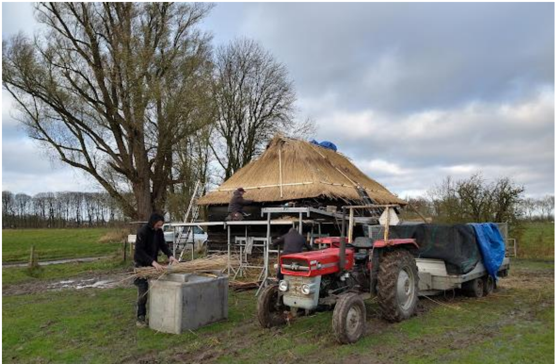
Vaklieden in actie tijdens de restauratie van het rieten dak van de loophut, december 2021
